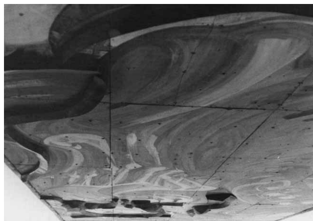
Figura 4 Grietas y roturas en las laminas de asbesto-cemento. Véase como se alinea la grieta con los tornillos de fijación. Abajo y a la izquierda se observan las aplicaciones metálicas. Foto: Grupo de Restauradores para el Poliforum, 1995
